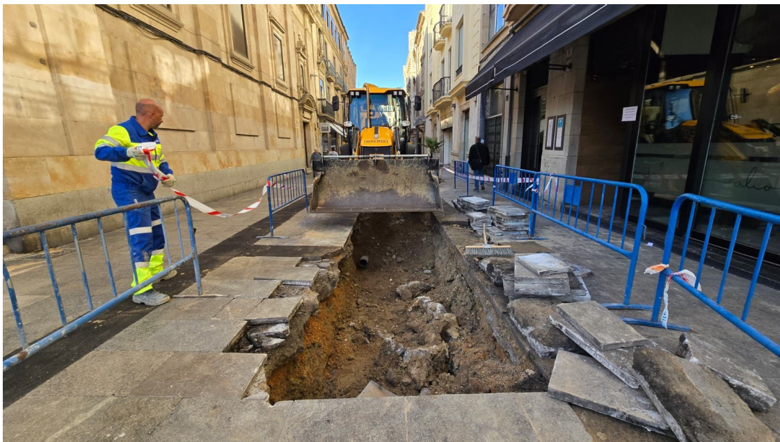
Obras por la rotura de una tubería de fibrocemento en la calle Azafranal
